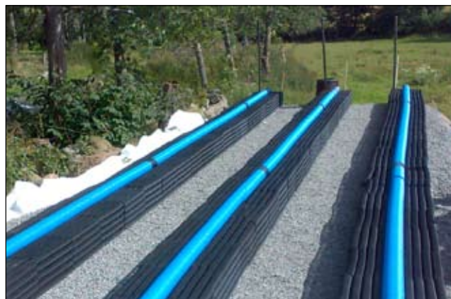
Markbädd för tre hushåll, under installation.
