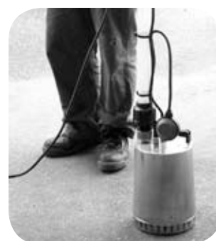
Pumpbrunnen är försedd med ett grönt plastlock. För att låsa locket monteras 2 stycken skruvar typ; borrande självgående M 8 x 30 rostfri som borraras igenom locket och fästs i brunnen.
