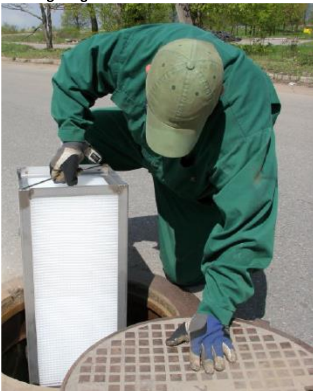
Fig.15. Koalescensmoduler/filter lyfts från oljeavskiljaren
