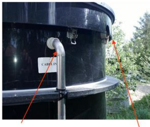
Kabelgenomföring till teknikenlådan
