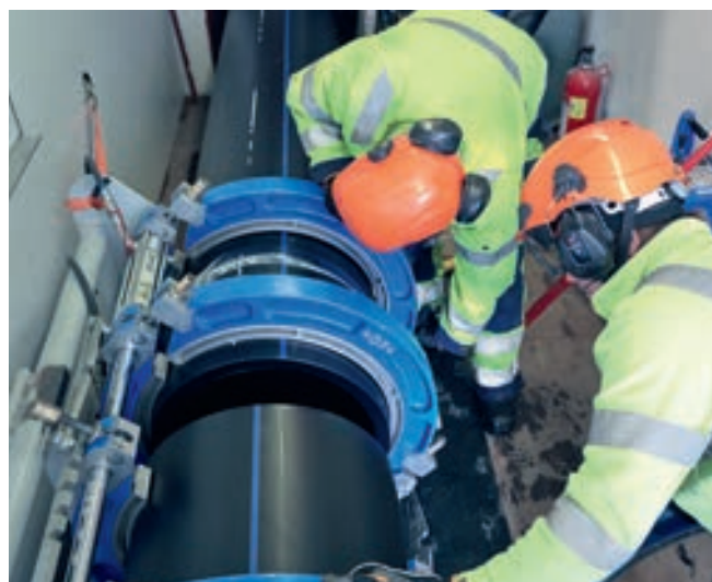
Vid skarvning är minimal ovalitet en förutsättning för säkra skarvar och ett effektivt arbete.
