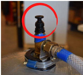
Tilläggsvattentankens avluftsventil (Om du beställde tilläggsvattentanken)
