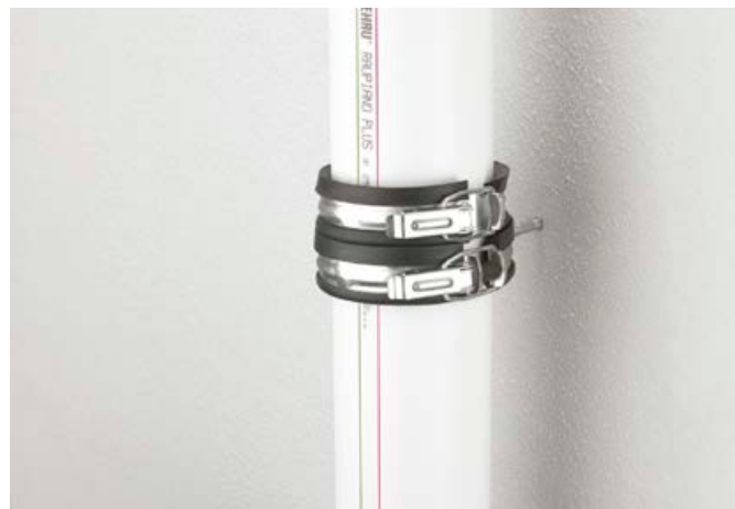
Fullständigt installerad klammer.
