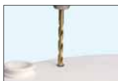
Borra ett hål på pumpens lock, 10 mm diameter
